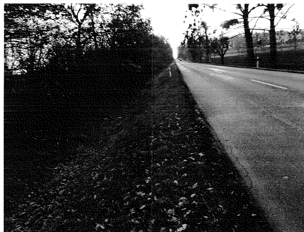
KM 0+950.00 KIERUNEK PRÓSZKÓW
