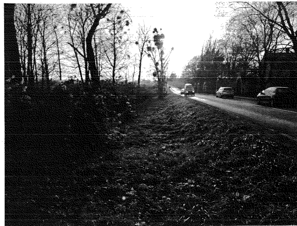
KM 0+100.00 KIERUNEK PRÓSZKÓW
