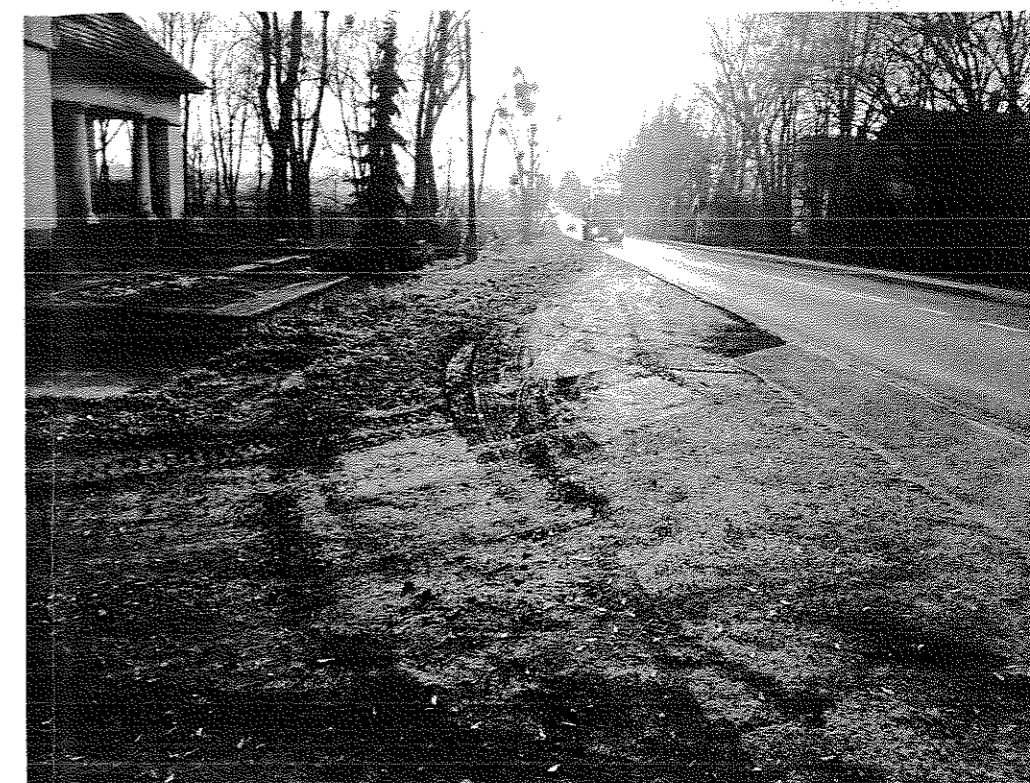
KM 0+180.00 KIERUNEK PRÓSZKÓW
