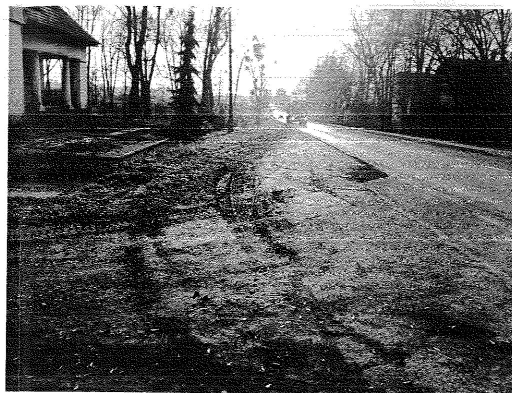
KM 0+180.00 KIERUNEK PRÓSZKÓW
