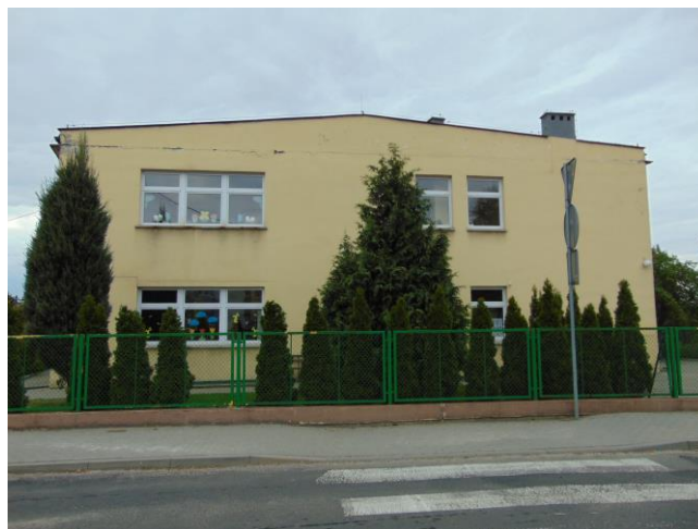
Elewacja boczna budynku przedszkola – widok ogólny
