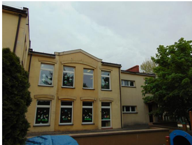
Elewacja tylna – widok ogólny Miejsce lokalizacji projektowanej wiaty.
