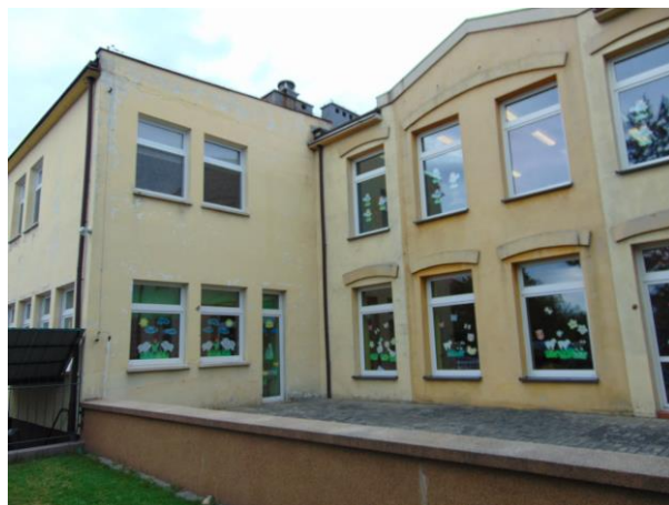
Elewacja tylna – widok ogólny
