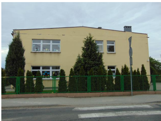
Elewacja boczna – widok ogólny
