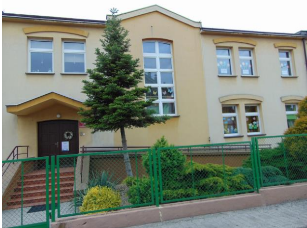
Elewacja frontowa – widok ogólny
